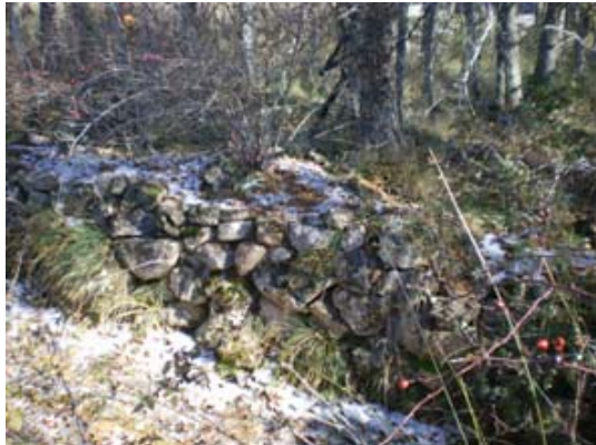
Foto 5: Muro de piedra en margen derecha
