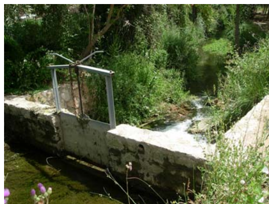
Foto 3: Azud El Molino, barrera para la fauna piscícola
