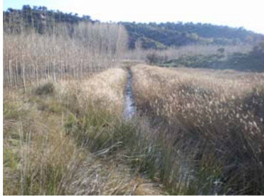
Foto 4: Canalización en tierras
