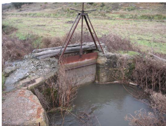
Foto 8: Azud Compuerta de Don Ramón, infranqueable para la fauna piscícola
