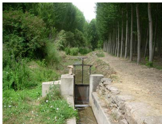
Foto 2: Derivación de agua para el riego de choperas productivas
