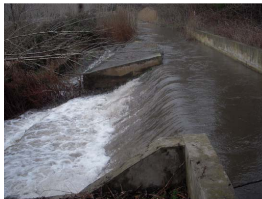
Foto 10: Azud El Zarzalejo, donde se propone la instalación de un dispositivo de paso de peces
